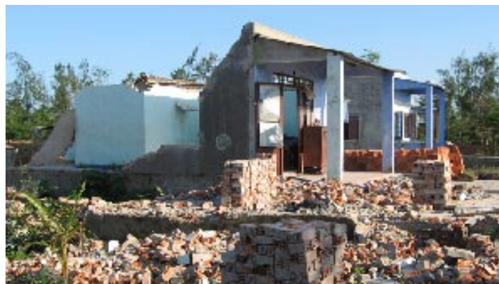
Nhà bị sập sau bão - Đà Nẵng, 11/2007
